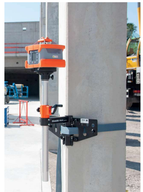
Bevestiging met band aan betonnen kolom
